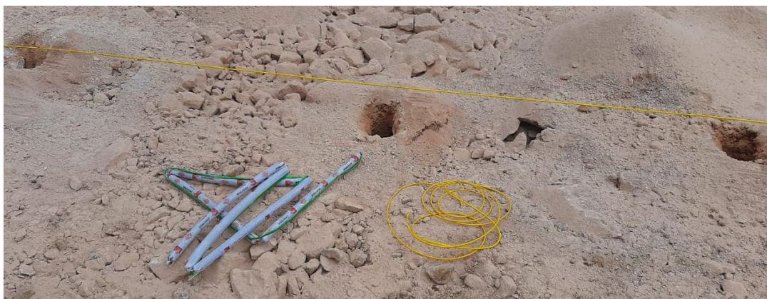
Fig. 8: Línea de cordón detonante
