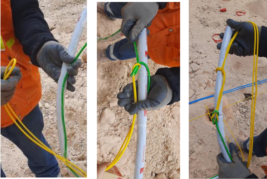
Fig. 10: Amarre de cordón detonante y emuline
