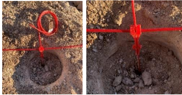
Conexión del detonador con cordón detonante
